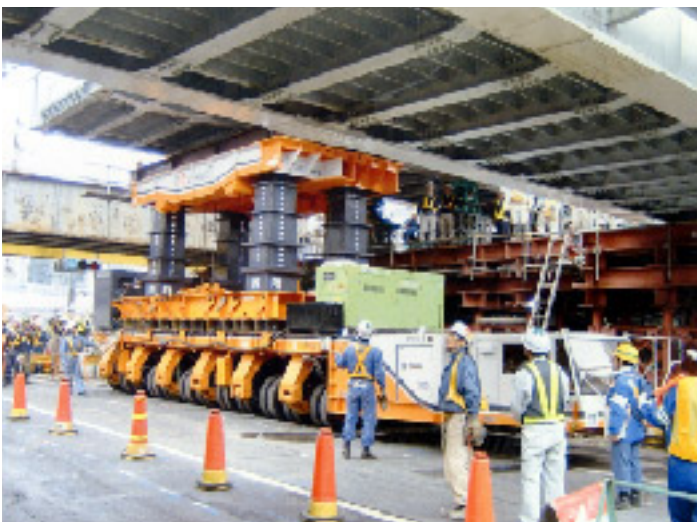
② JR浜松町、跨道橋架け替え工事
