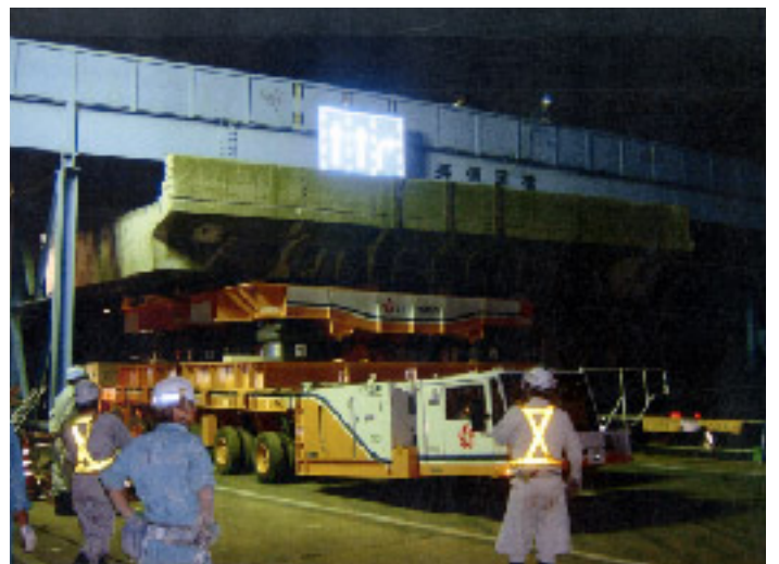
③ 国道254号 新座インターチェンジ、本線橋撤去工事
